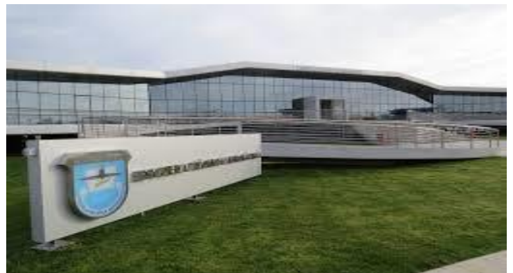
Instalaciones en San Pablo.
