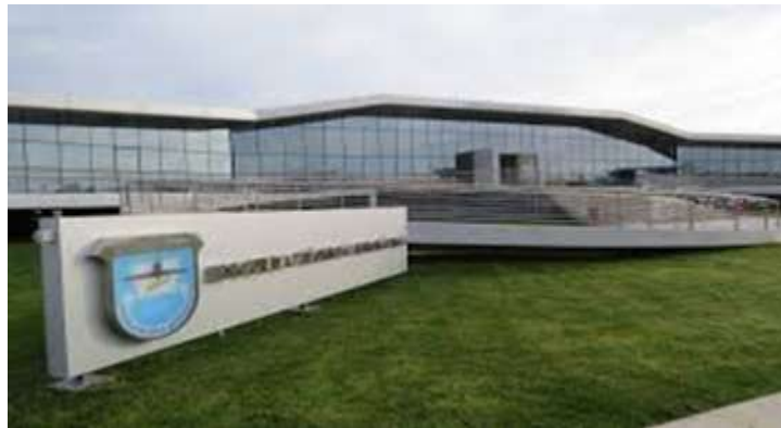
Instalaciones en San Pablo.
